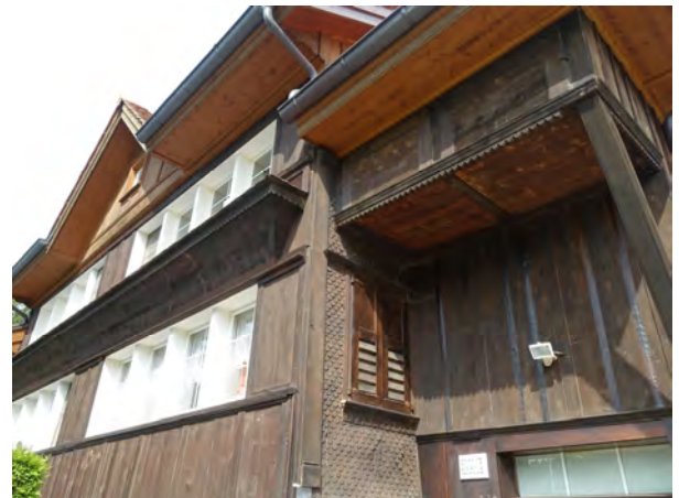
Fassadendetails Hauptfassade / östlicher Anbau
