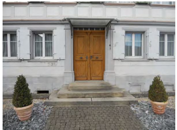
Eingangstüre mit dreistufigem Eingangspodest
