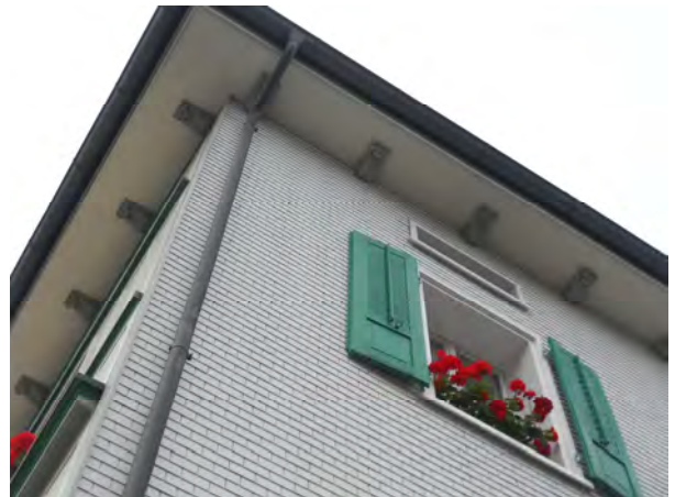
geschnitztes Gespärre unter geschlossener Traufe
