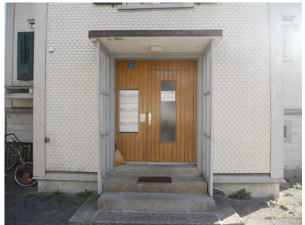
Gebäudezugang auf der Rückseite
