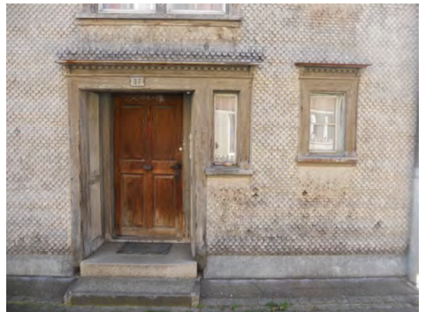
Rückseitiger Gebäudezugang im Anbau
