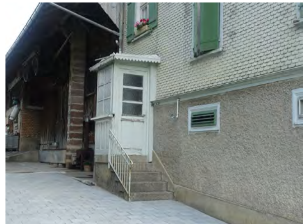
Hauszugang an der Rückseite
