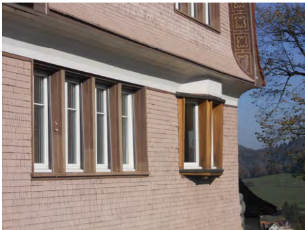
Erker an der Südfassade; bemalte Traufe
