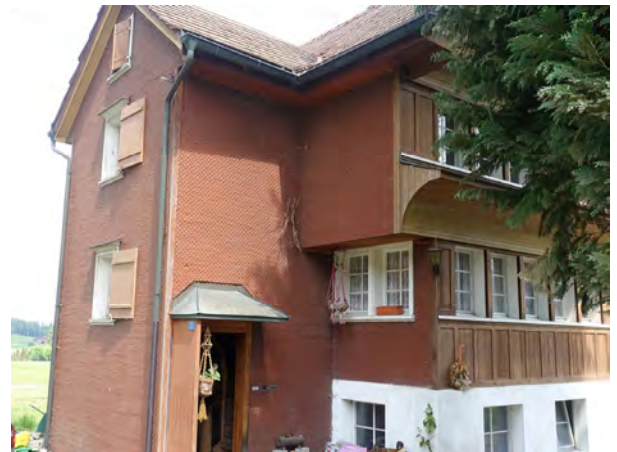
östlicher Anbau mit Eingangssituation
