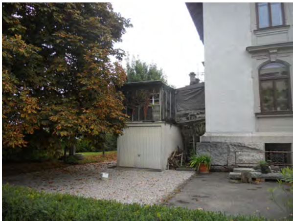
Garagenbox mit Aufbau auf der Ostseite des Gebäudes
