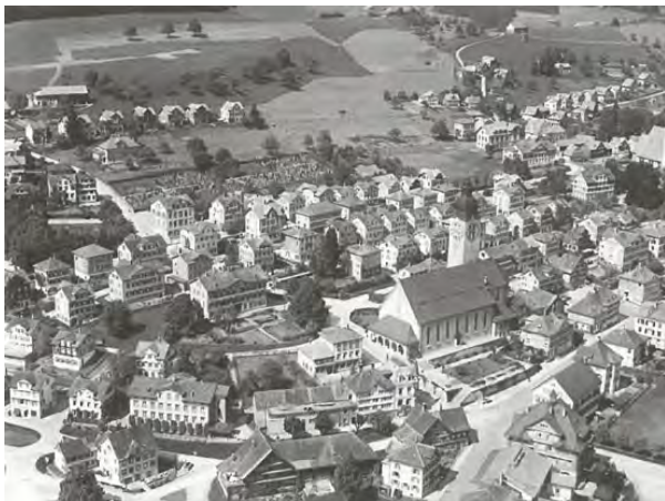
Historische Aufnahme: Bauernhaus Mitte unterer Bildrand
