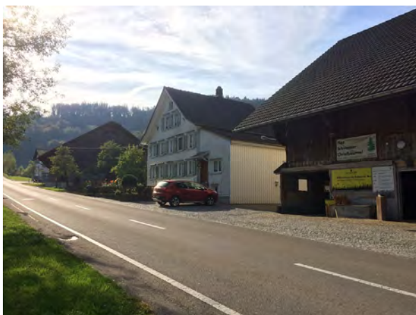
Ansicht im Strassenverlauf
