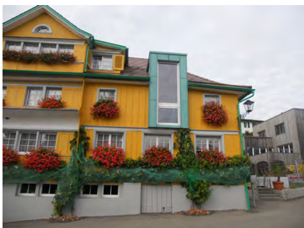
Neue überhöhte Gaube
