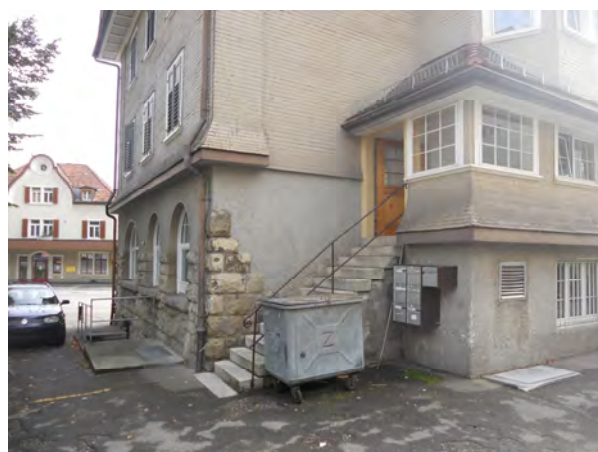
Zugang Obergeschosse auf der Rückseite
