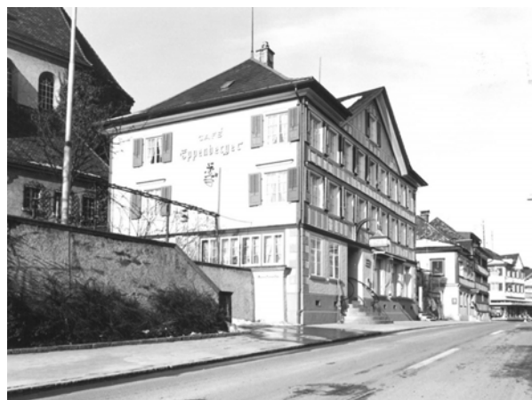
Aufnahme vor der Renovation von 1976
