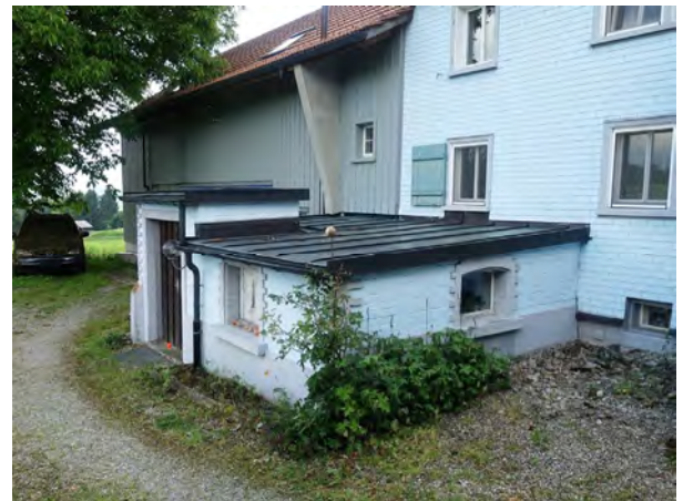
rückwärtige Fassade mit Mostereianbau
