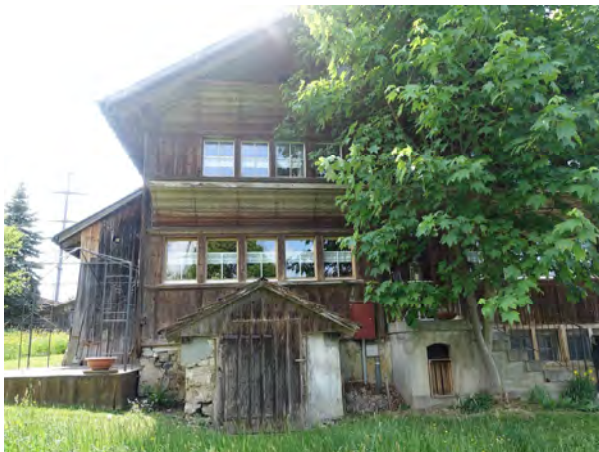
Kellerzugang und Sitzplatz
