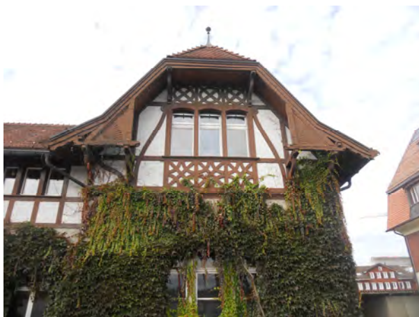
Giebfeldgestaltung mit Fachwerk, Gespärre und Ortgangbrett
