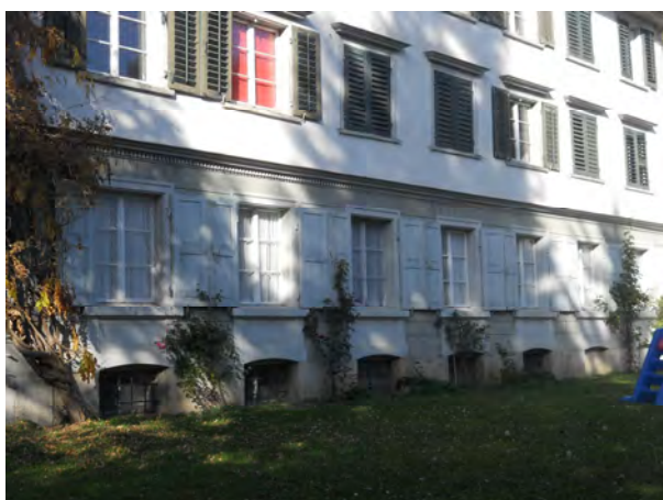
Sockelgeschossgestaltung mit Kellergeschossfenster
