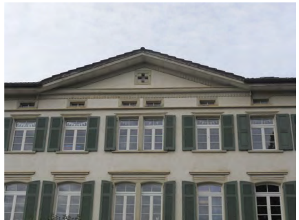
Quergiebel an der Hauptfassade
