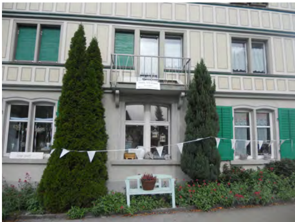
Hauptfassade mit Balkon über Sockel, ehem. Gebäudezugang
