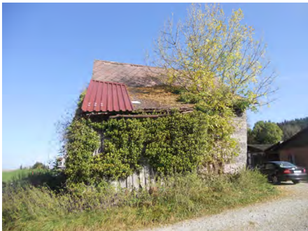
Ansicht von Westen mit provisorischer Dachsanierung
