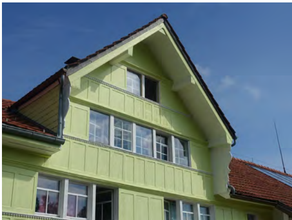
Kreuzgiebel mit den seitlichen Windbrettern
