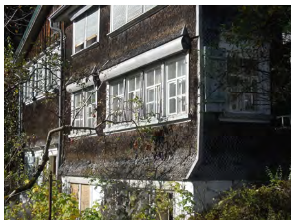
Fassade mit Abwürfen und Rollladenkästen
