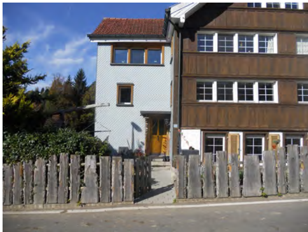
Anbau mit Hauszugang; Verbundsteinpflasterung und Zaun
