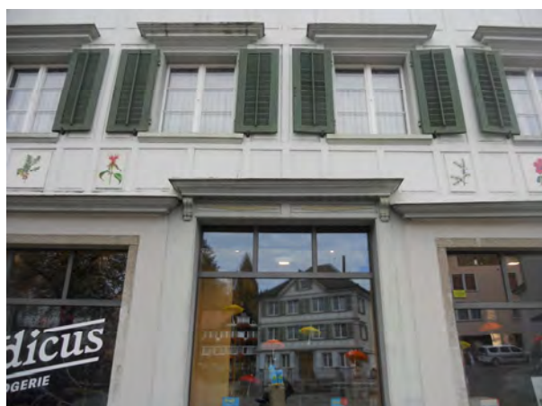
Versatz Gurtgesims über ehemaligem Gebäudezugang
