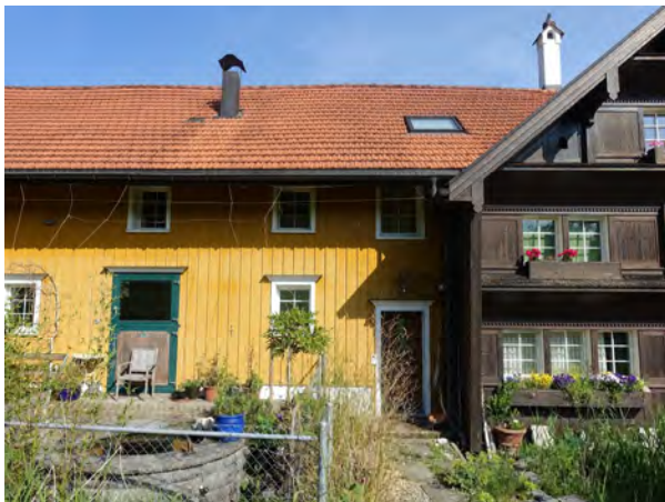
Übergang Wohnhaus - Stall mit ursprünglicher Eingangstüre
