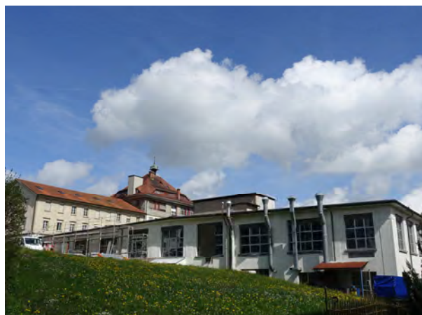
Eisenbetonsaal / Dachaufbau auf Zentralbau im Hintergrund
