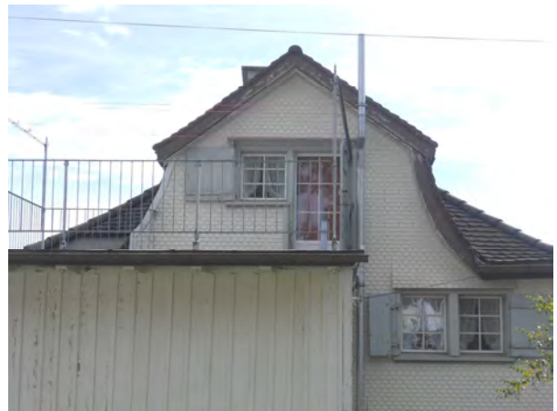
Abgeschnittenes Mansardendach beim Anbau
