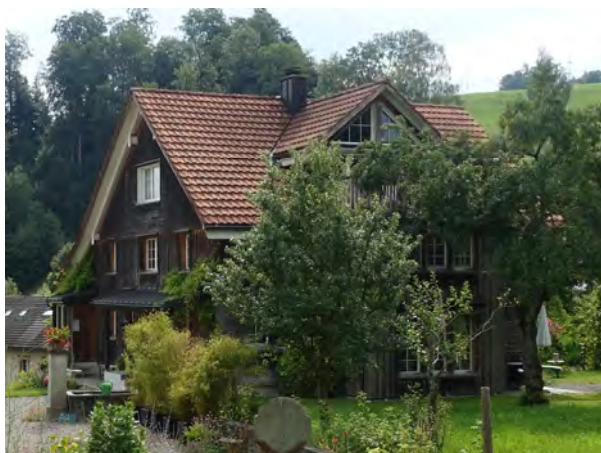
Rückwärtige Fassade mit Platzgestaltung
