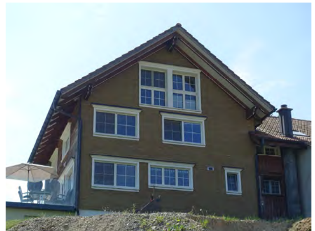
Neue Fenster an der Rückfassade
