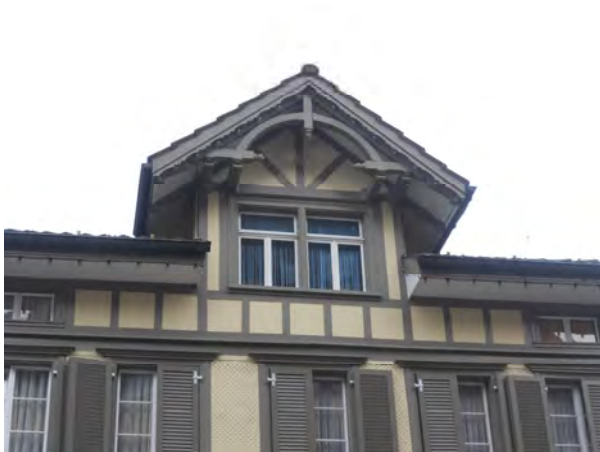
Quergiebel mit sichtbarem Gespärre
