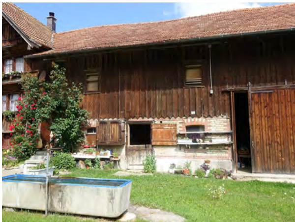
Mauerwerk und gezackter Leistenschirmabschluss bei Stall
