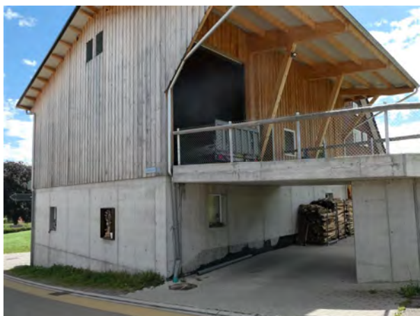
Rückseite Ökonomiegebäude mit Hocheinfahrt
