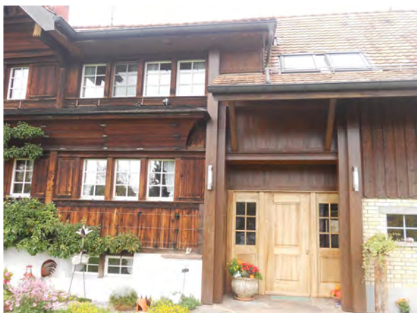
Übergang Haus - Stall mit neuem Hauszugang
