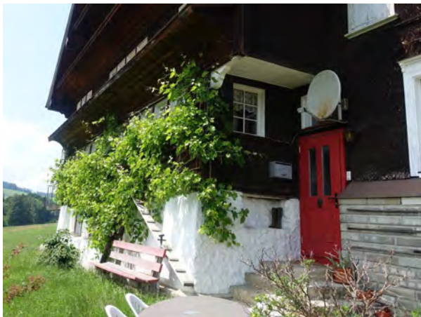
Eingang und Sockelgestaltung an der Hauptfront
