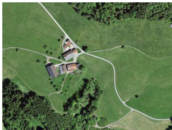
Anordnung der Bauten (Orthophoto geoportal, 2019)
