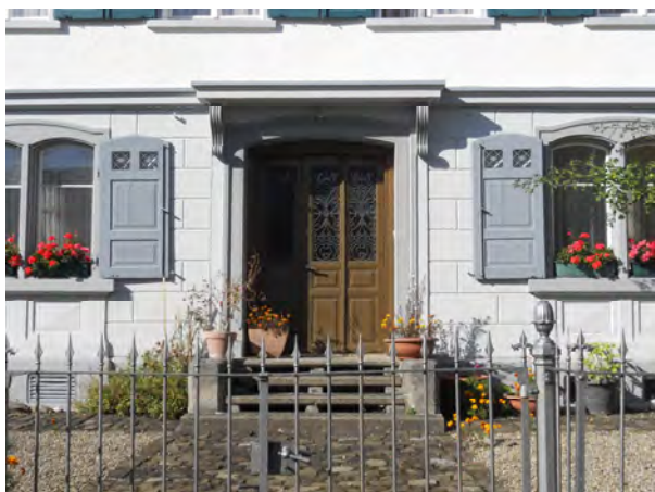
Zugangportal mit offener Zugangstreppe (Steinplatten)
