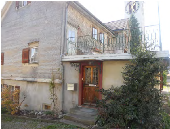
Rückseitiger Anbau mit separatem Eingang
