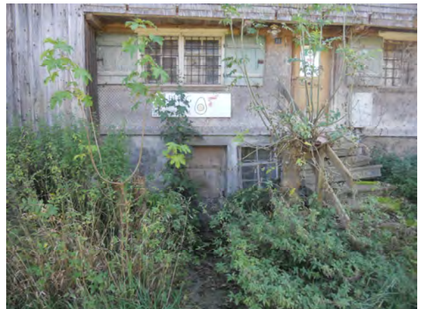
Haus und Kellerzugang auf der Strassenseite
