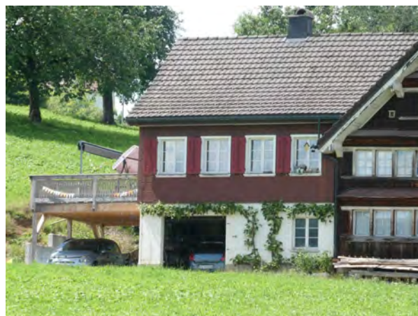
Carportanbau mit Terrasse westseitig
