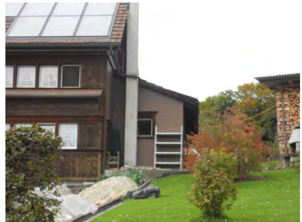
Ostseitiger Anbau mit Kamin und Sonnenkollektoren
