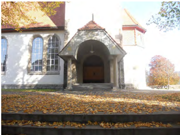
markanter Eingang auf der Westseite
