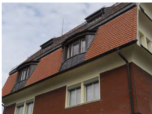
Polygonale ausgeformte Dachgauben an der Westfassade
