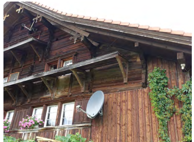
Fassadenübergang Hauptfassade - Anbau
