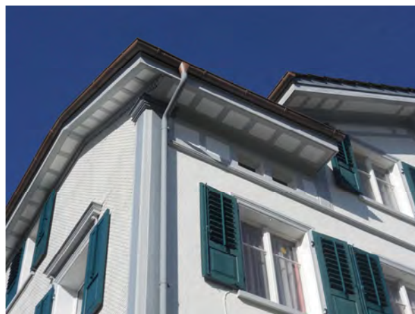
Dachuntersicht mit Eckpilaster
