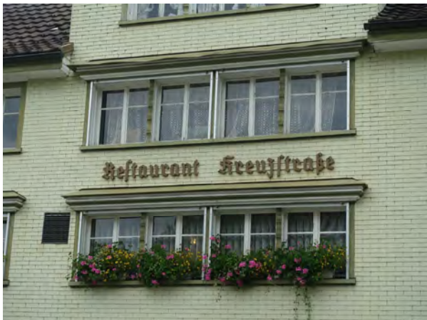
Hauptfassade mit Schriftzug
