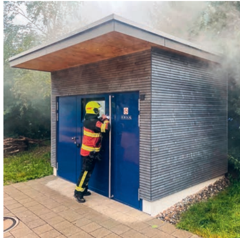
Beim Brand in der WC-Anlage am Eisbahnweg entstand ein Sachschaden in der Höhe von rund 50 000 Franken. Bild: Kantonspolizei St. Gallen
