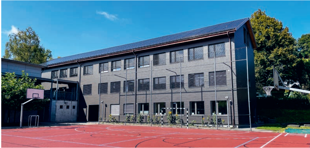
Die Sanierung des Schulhauses Steinegg Nord erfolgte termingerecht und innerhalb des Kreditrahmens.
