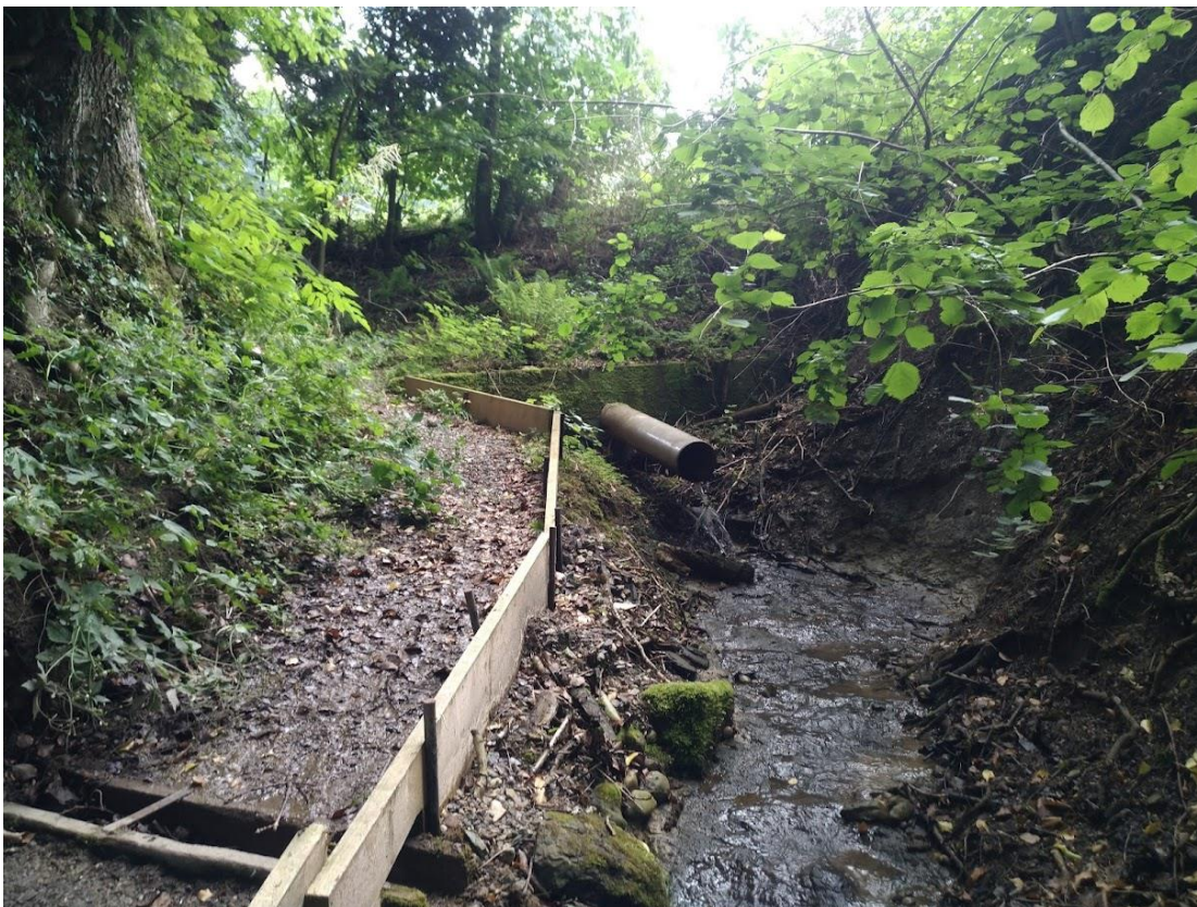
km 0.030, Blick entgegen Fliessrichtung: Übergang Bacheindolung in bestehenden, offener Gewässerverlauf, Nagelfluhsohle
