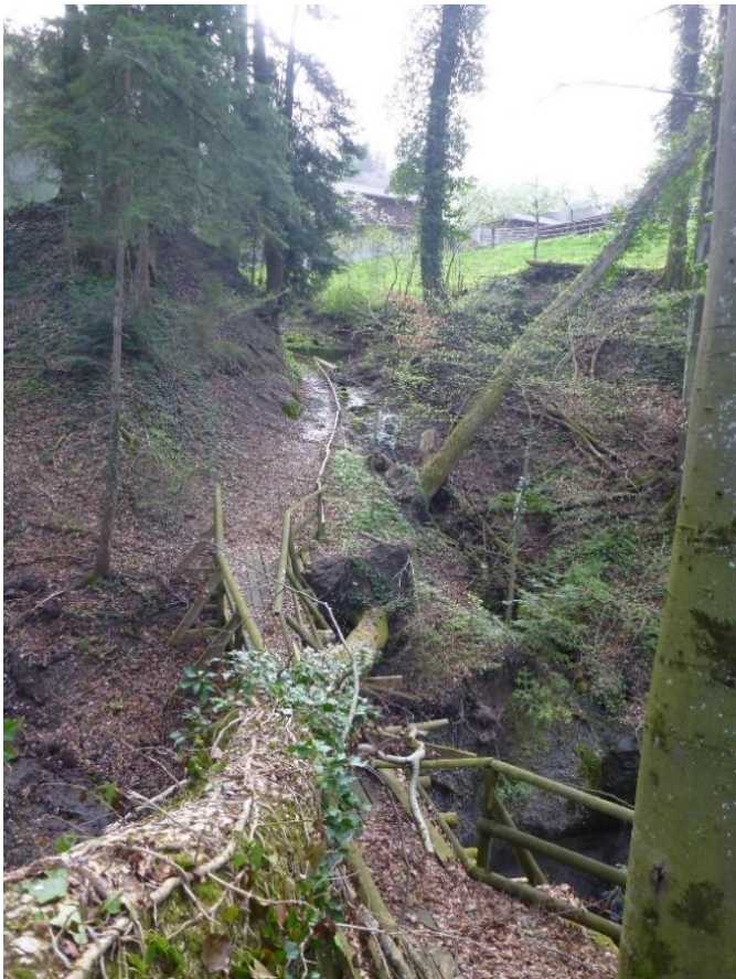
km 0.010 – km 0.30, Blick entgegen Fliessrichtung: Teilstück bestehender, offener Gewässerverlauf, Sohle harter Nagelfluhfels, Bestehender Autobelweg mit zerstörter Brücke. Aufhebung im Teilstrassenplanverfahren «Aufhebung Autobelweg», Gemeinde Degersheim.
