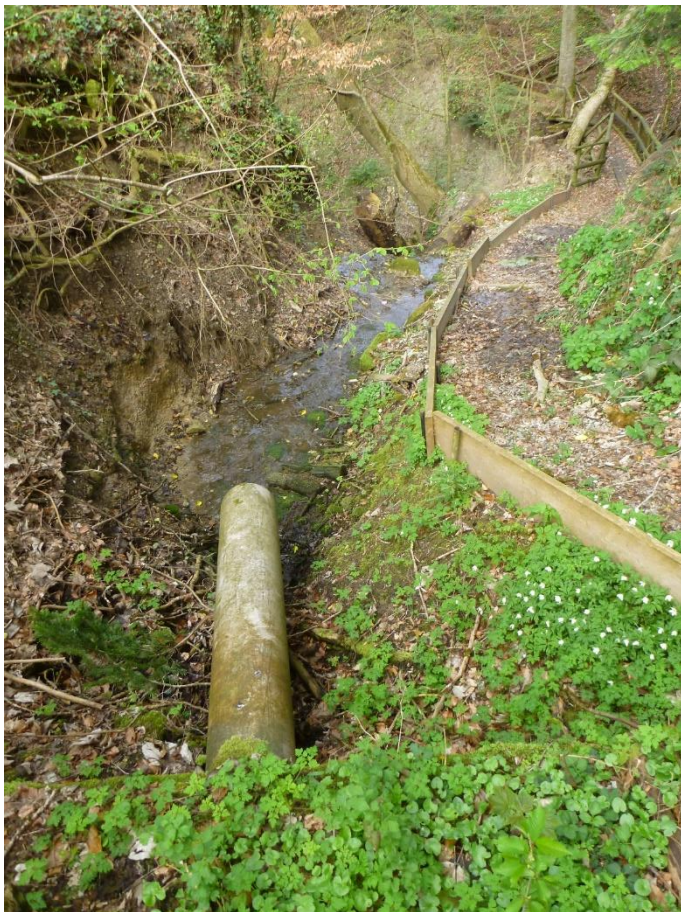
km 0.030, Blick in Fließrichtung: Übergang Bacheindolung in bestehenden, offener Gewässerverlauf, Nagelfluhsohle
