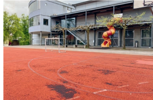
sanierungsbedürftig und wird demnächst ersetzt.
